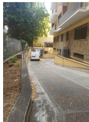
ACCESS RAMP 1 Via Dei Tizii, 6d (approx. 8% incline)
