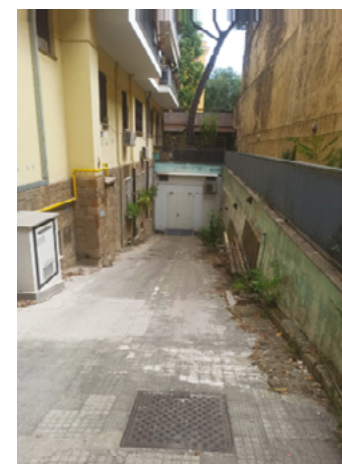
ACCESSO RAMPA 2 Via Dei Tizii, 2b (pendenza circa 10%)
